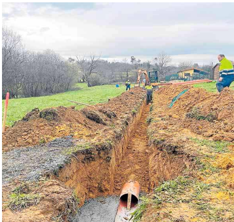
Operarios en las labores de construcción de la nueva red de saneamiento de la zona de Límanes, en Siero. E. C.
