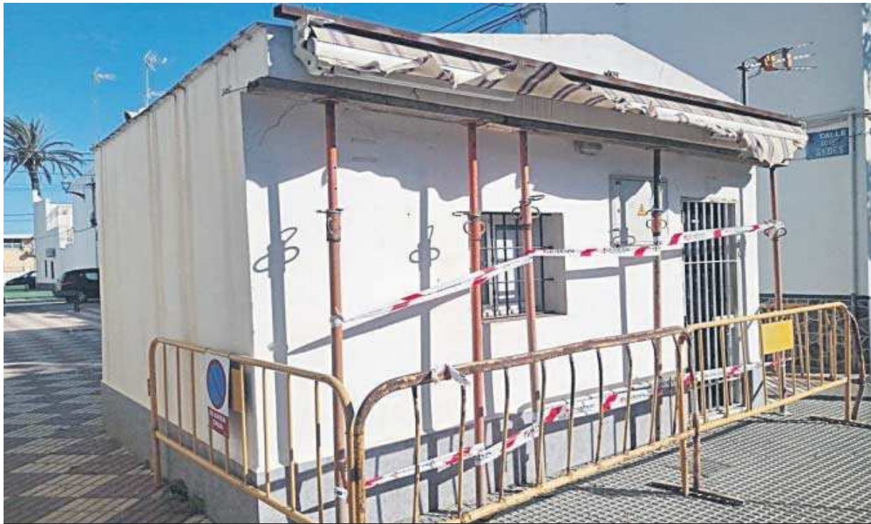
Una imagen del quiosco cerrado y apuntalado por las obras del tanque de tormentas.
